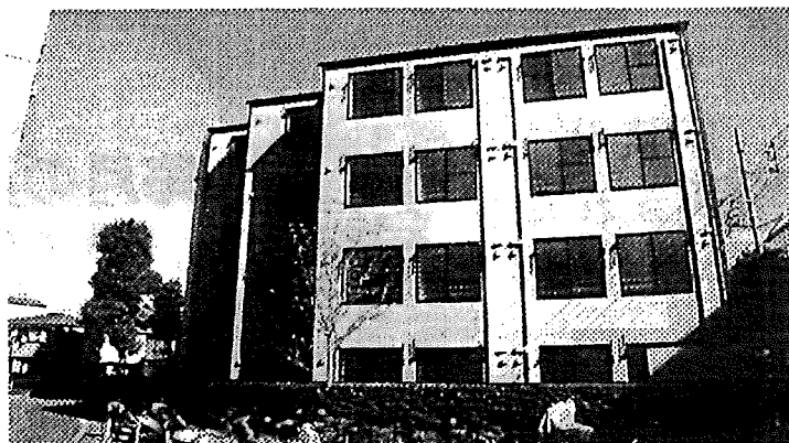
▶同社が施工した利回り10%の賃貸アパート(11月施工)
