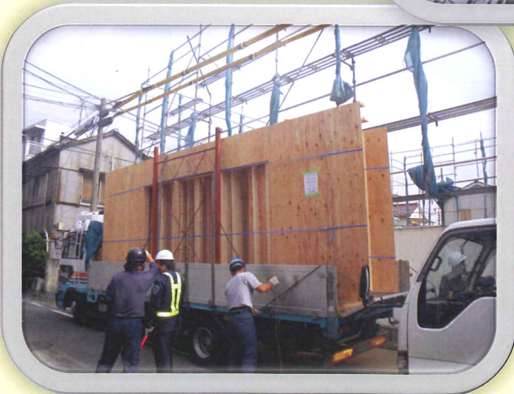
パネル工法で施工中
